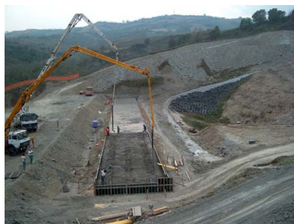
Esecuzione soletta di collegamento pali in ca
