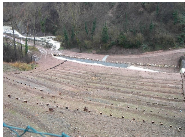
Interventi di ingegneria naturalistica pendice in frana
