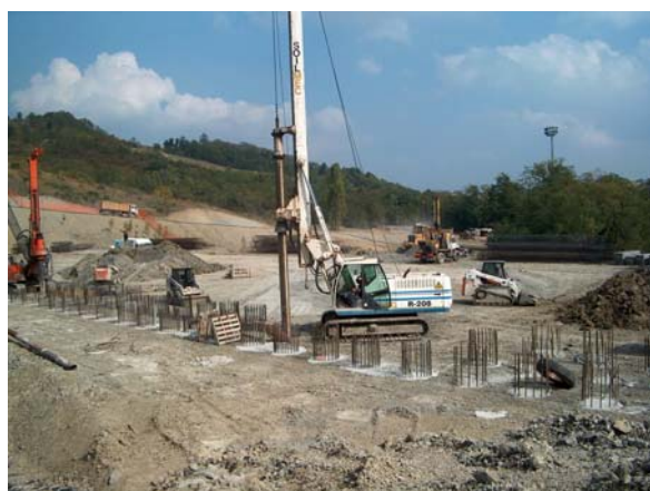
Esecuzione pali in ca argine di valle alla discarica
