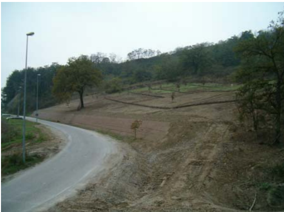
Terra armata lato strada di accesso alla discarica
