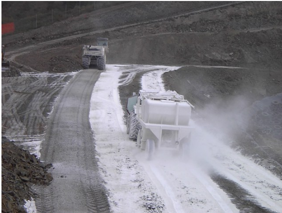
Esecuzione stabilizzazione a calce argine di valle
