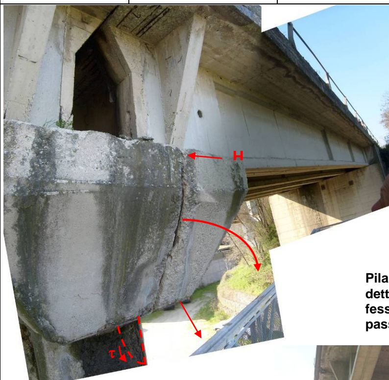
Vista pulvino-impalcato lato San Leo: possibili cinematismi di collasso
