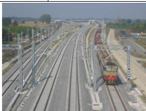
Gallerie artificiali Interconnessione Modena Est – Transito di un convoglio
