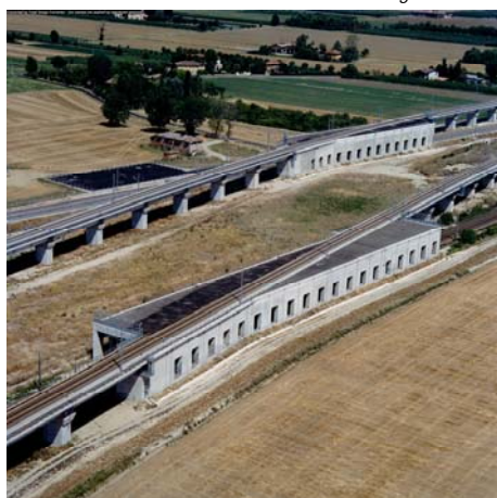
Vista delle gallerie artificiali dell'Interconnessione Modena Est entrambe oggetto di collaudo
