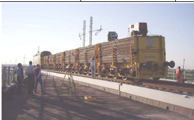
Prova di carico galleria artificiale GA17 – Interconnessione Modena Est
