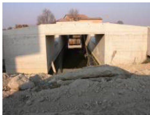
Sottopasso scatolare lungo linea
