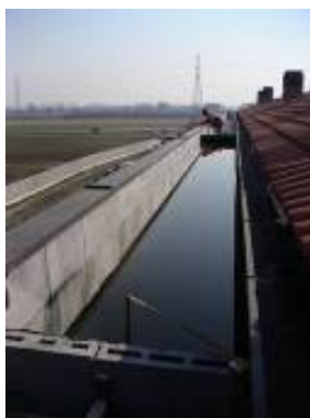
Prova di carico di un fabbricato tecnologico
