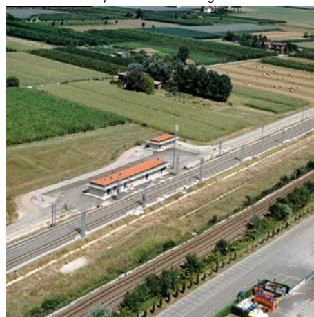
Vista di un fabbricato tecnologico oggetto di collaudo
