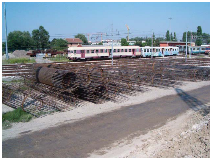
Luglio 2004 Gabbie per i pali a lato delle gallerie artificiali
